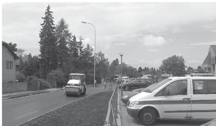
asfaltu je třeba znát konečnou výšku vozovky a do této výšky zvednout uvedené uzávěry. Až poté kolem nich lze položit asfalt a to ráz na ráz, než by došlo k poškození těchto nad povrch vyčnívajících uzávěrů.
